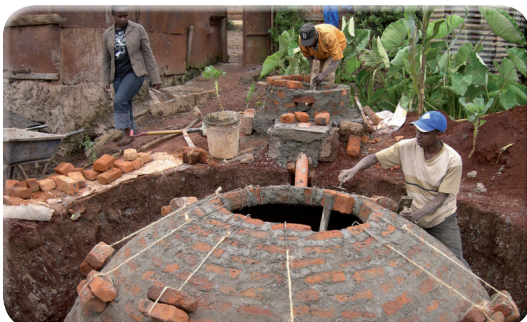
Beispiel Kenia: Biogas aus Kuhdung
