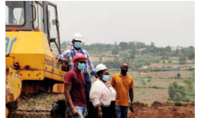
Kigali, Ruanda: Start der Bauarbeiten für die neue Ofenfabrik
