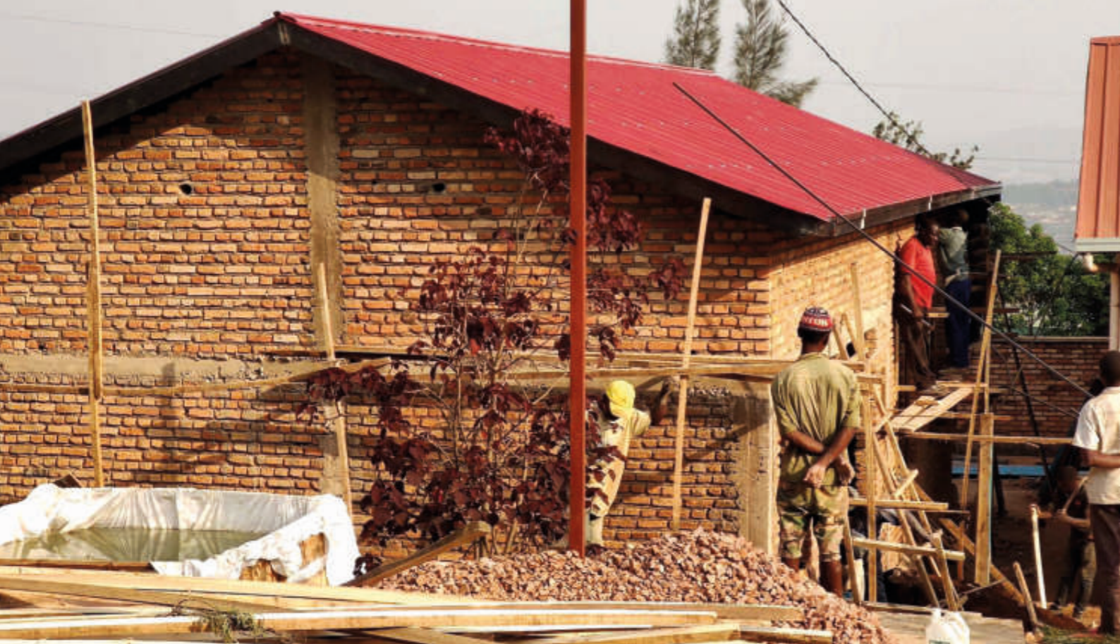
Ein neues Lagerhaus in Kigali bietet Platz für Ofenteile zur Endmontage
